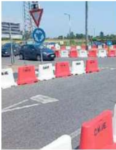
Viabilità lungo la SP 33
